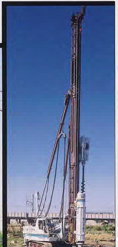
油圧ハンマ+油圧オーガ併用作業
