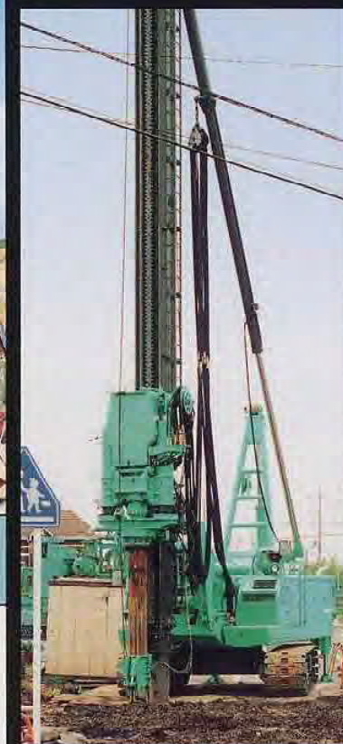
シート圧入作業
