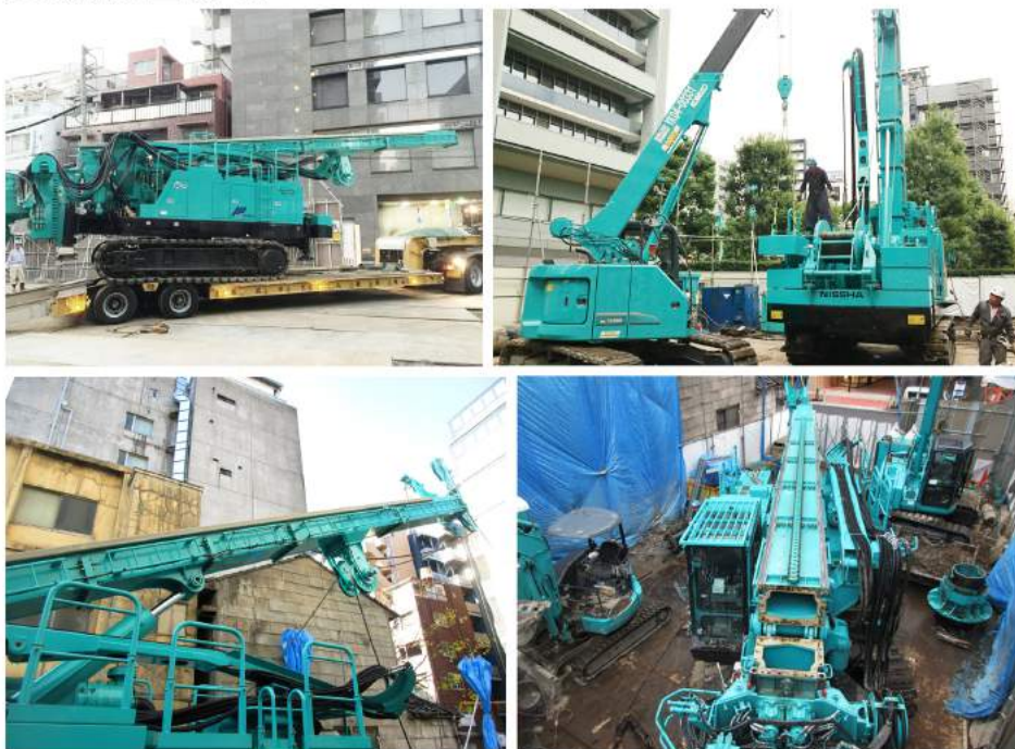
運搬組立解体
