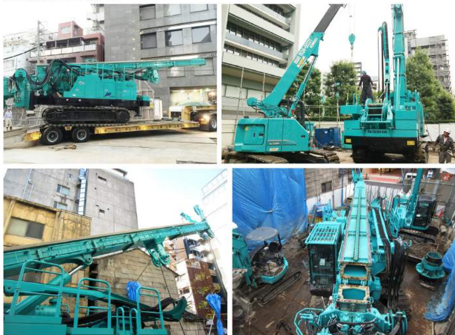
運搬組立解体
