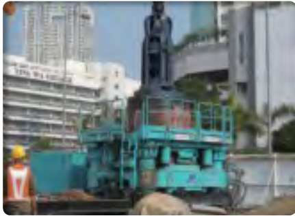
地中障害物切削
